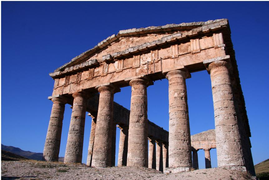
Figura 2.12: O Templo Grego de Segesta, exemplificando alguns aspectos da Ordem Dórica. Este templo nunca chegou a ser terminado, sendo visível, por exemplo, a falta das caneluras nas colunas. Fotografia de Enzo De Martino.
