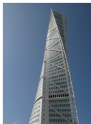
Figura 5: Turning Torso. Fotografia de Warsaw.
